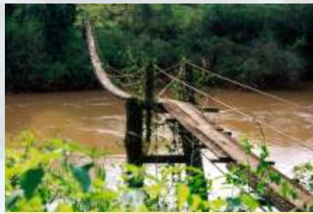
PONTE SOBRE O RIO JACUTINGA.
